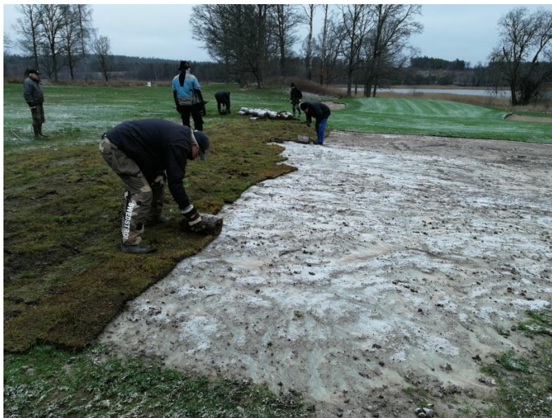
Utfyllda "kärring-skräcken" täcks med torv. Närmast i bild är Per-Olov. (K-E tog bilden 181122)
