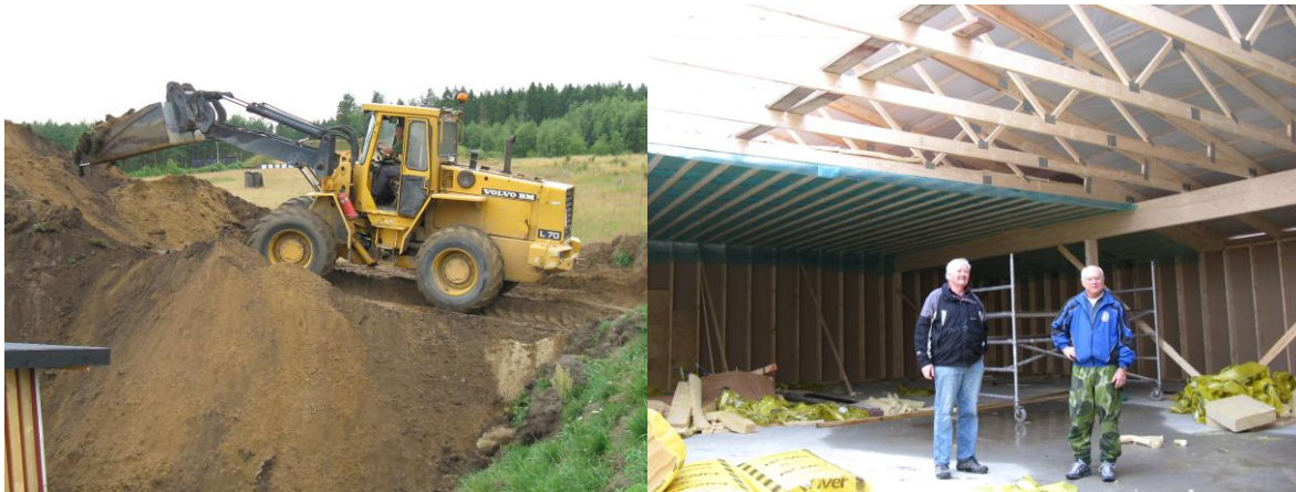
T.v. "Första spadtagen" tar Sven Olsson för bygget hösten 2008. T.h. Bengt Nilsson och Erik Nilsson inspekterar bygget när det var halvvägs kommet
