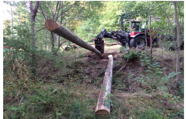
Edvard Säaf från Säafs Maskingrävning lade med sin stora maskin den 7/9 ut elstolparna som broarna ska byggas av.
